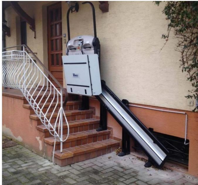
El equipo Salva Escalera que se consulta es del tipo "Modelo V64 del fabricante Vimec" o su equivalente técnico o superior, el cual debe ser instalado de acuerdo a recomendaciones e instrucciones del fabricante.
